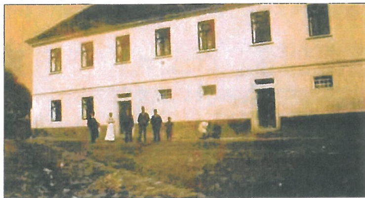
Sokolovna před přestavbou
